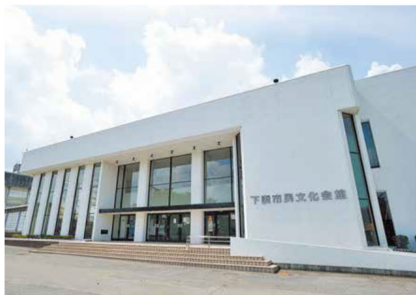
▲市民文化会館改修に向け、まずは調査を進める
