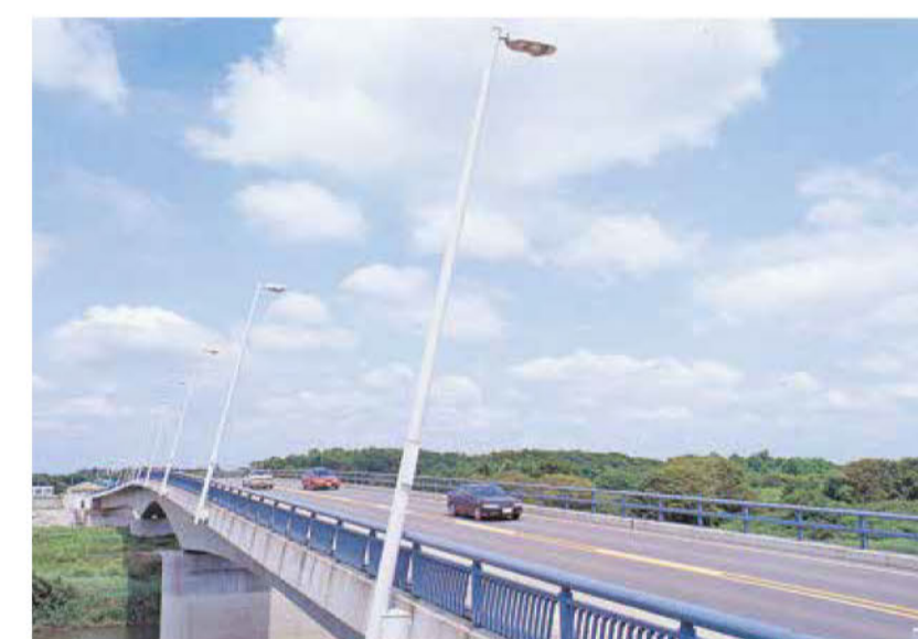
▲水海道大橋を含む延長2.7kmの水海道有料道路
