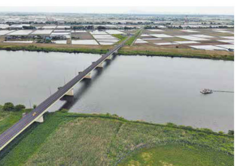
▲茨城県と千葉県を結び、利根川に架かる若草大橋
