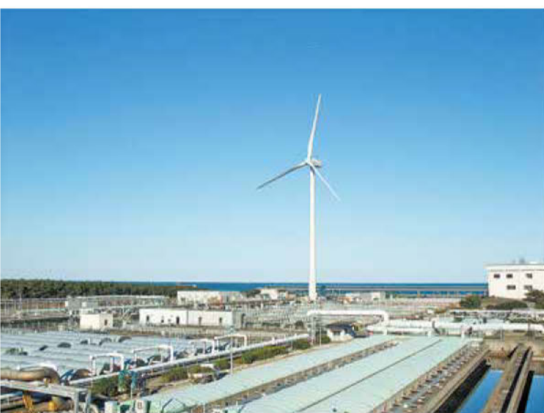
▲深芝処理場内にある、風力発電設備
